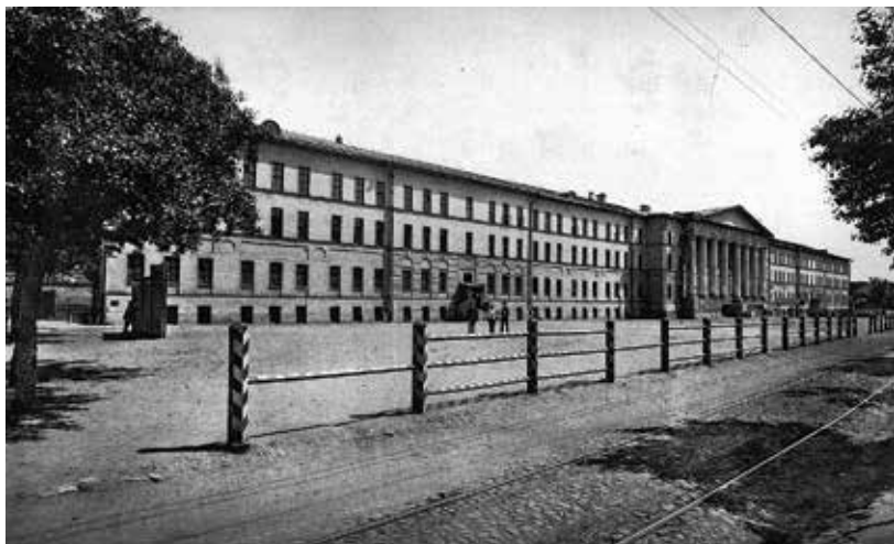
Ил. 1. Покровские казармы в 1910-х годах. Фото из «Альбома зданий, принадлежащих Московскому Городскому Общественному Управлению». Т. 1. С. 192.
