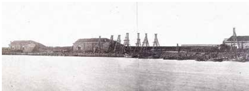
Ил. 38. Северная морская батарея № 1. Начало работ по постройке центральной казематированной казармы. Насыпка высоких брустверов еще не начата, благодаря чему на фото запечатлен первоначальный силуэт батареи с пониженными брустверами между казематированными траверсами. Фото 1869 г. Из фондов ВИМАИВиВС
