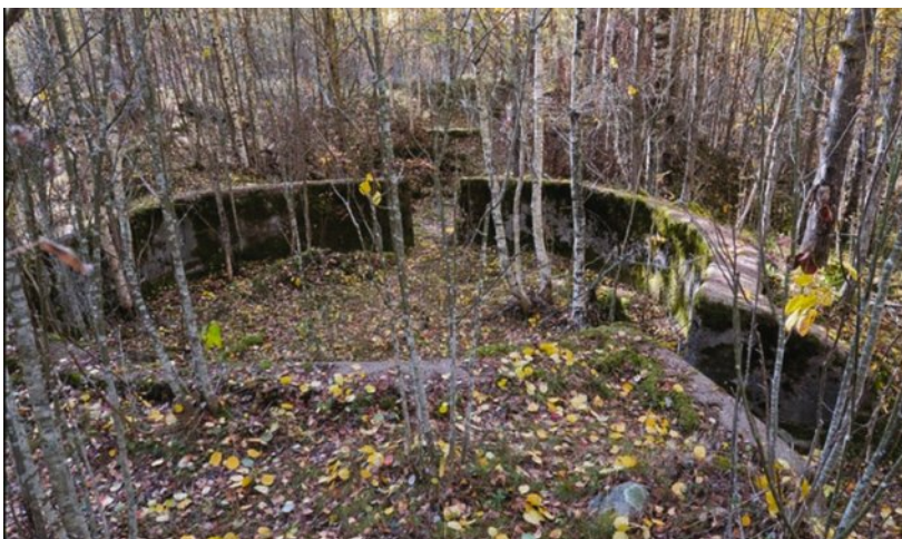
Ил. 19, 20. Современное состояние оружейных двориков левофланговой батареи 152-мм батареи на лафетах Вавассера. Фото 2019 г. Е. Балашова
