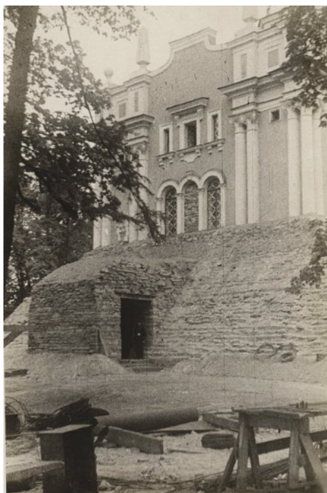
Ил. 14. Земляные работы по устройству потерны между ФКП и КП ВС. На снимке видны срубы, установленные перед входом в сооружение и образующие сквозник. На заднем плане видна обваловка первого этажа КПВС
