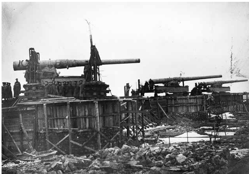
Ил. 17. Процесс установки 10-дюймового орудия на батарее «Риф». Декабрь 1909 г. Фото из семейного архива потомков Л. П. Катицы
