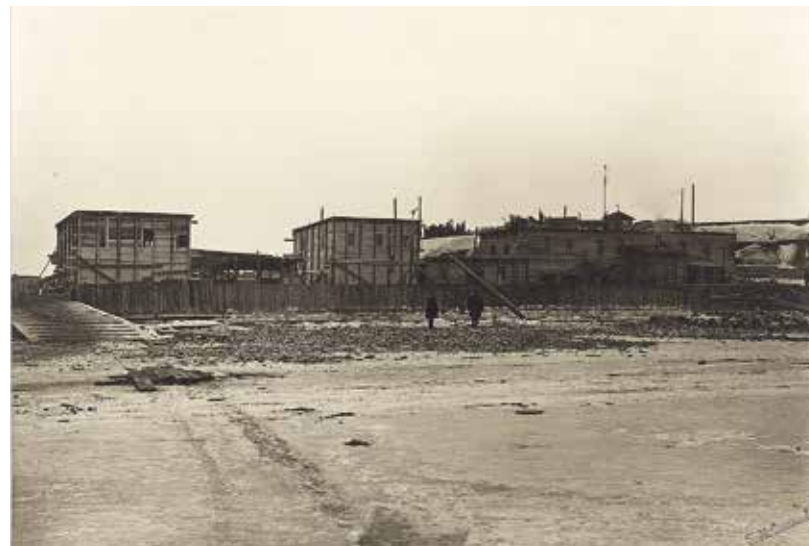
Ил. 19. Процесс бетонирования оснований северной 6-дюймовой батареи. Фото марта 1910 г. РГАВМФ. Ф. 418. Оп. 1. Д. 6090
