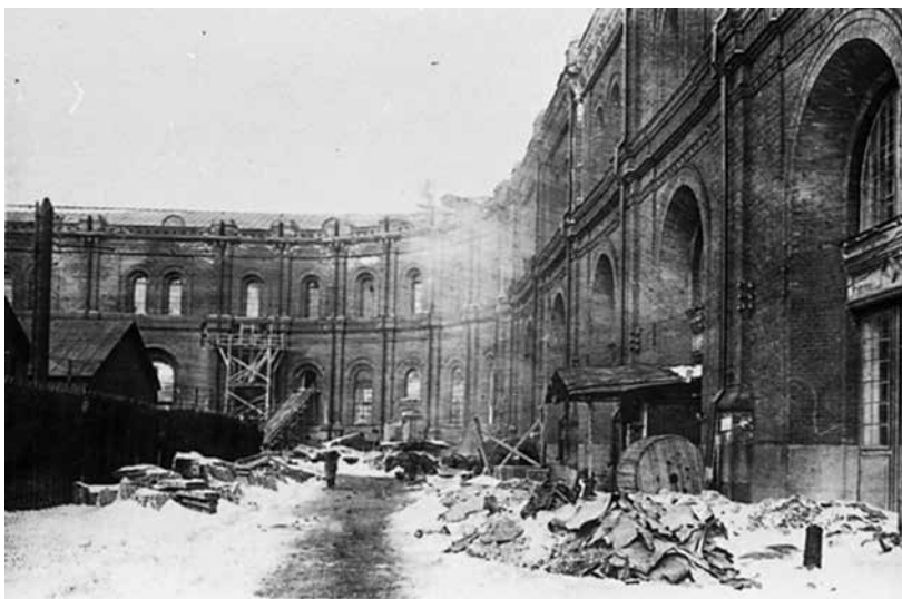
Ил. 5. Разрушения здания Кронверка от бомбардировок и артобстрелов. Зима 1942 г. ВИМАИВиВС. Фонд фотодокументов. Инв. № 7/500–8
