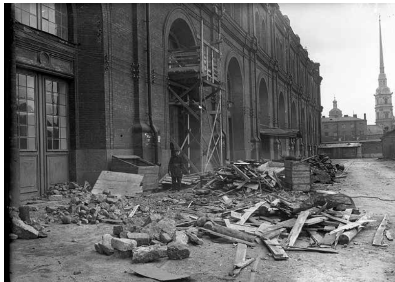
Ил. 7. Вид части здания Кронверка, где располагался АИМ после артиллерийского обстрела весной 1942 г. Научный архив ВИМАИВиВС. Ф. 3 Р. Оп. 2. Д. 403. Л. 8
