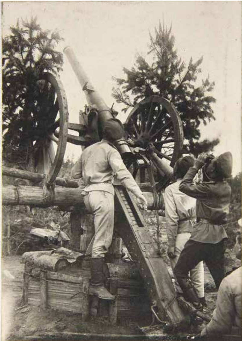
Ил. 24. «По аэроплану». Установлена 3-дюймовая полевая пушка образца 1900 года. Хорошо виден каучуковый накатник
